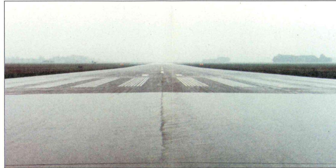
Der gerillte Pistenbereich ist fast trocken, während auf der nichtgerillten Fläche das Wasser steht.
